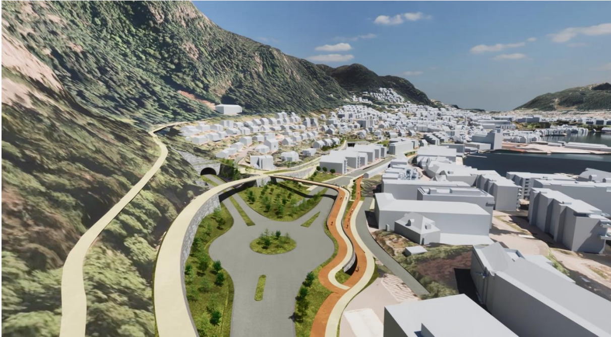
Figur 6-32: Rundkjøring ved Glass Knag, sett fra nord.
