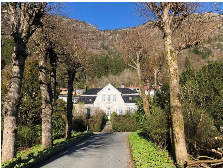
Figur 5-3: "Brødretomten" i Amalie Skrams vei med allé som strekker seg ned mot Sandviksveien.
